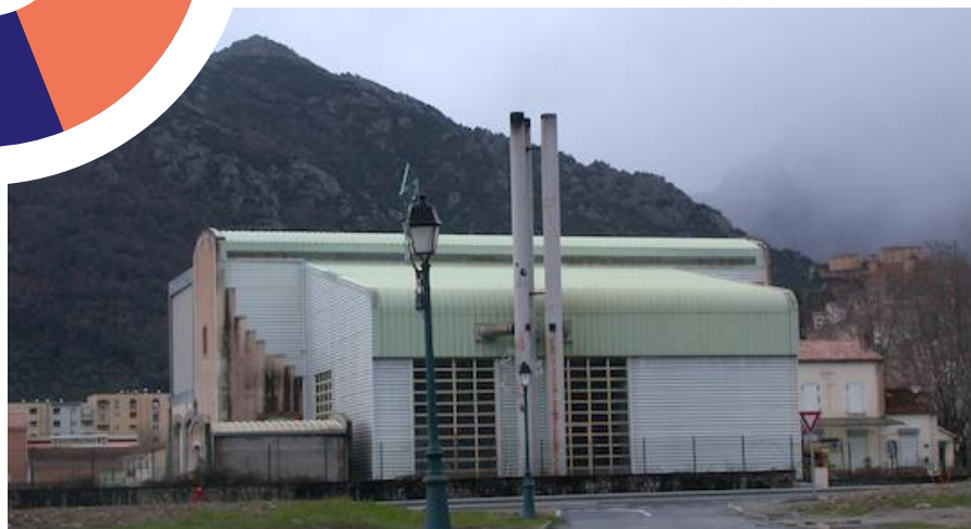
La chaufferie biomasse du réseau de Corte © Frédéric Douard
