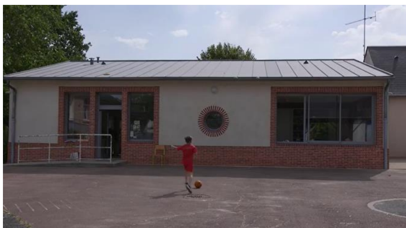
ÉCOLE DE SAINT-AURICE-SUR-FESSARD CHAUFFÉE PAR LA GÉOTHERMIE © ADEME, watts.new
