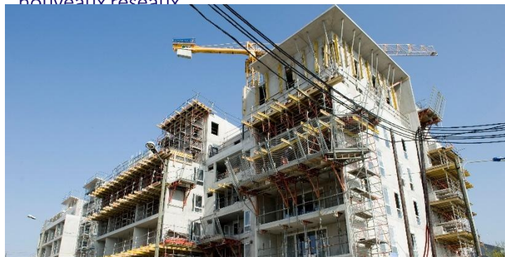
Bâtiment de logements collectifs en construction Crédit : Bernard Suard - Terra
