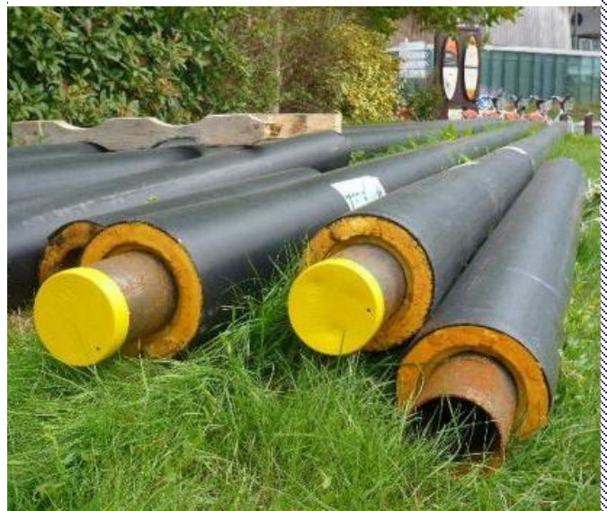
Canalisations isolées en attente de pose
