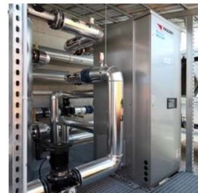
Figure 56: groupe froid à absorption (Serm)
