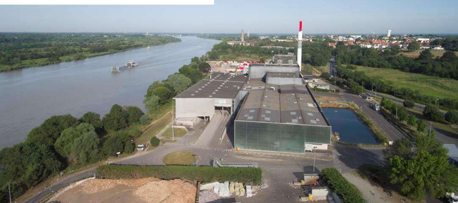
UVE Arc-en-Ciel Nantes © Oliver Naves - Drakodrone
