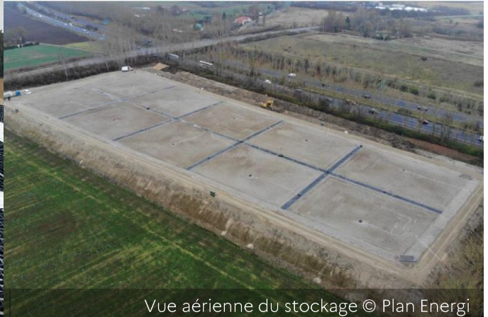
Surface du stockage en fin de construction
