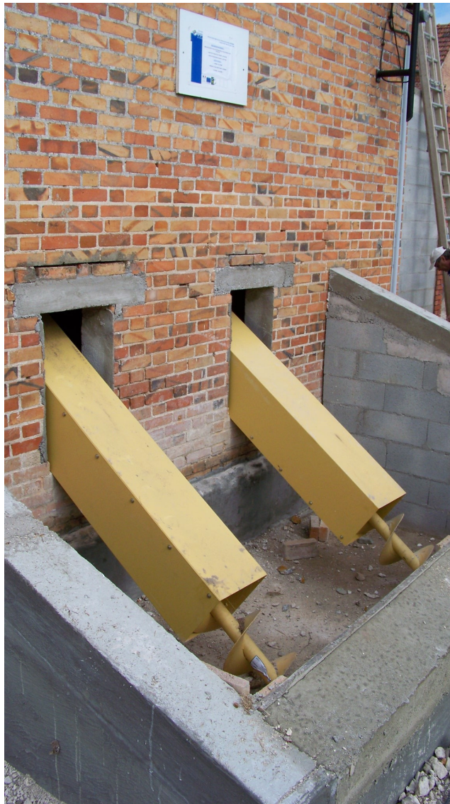
Photo: Vis sans fin pour alimentation chaudière (DREAL)
