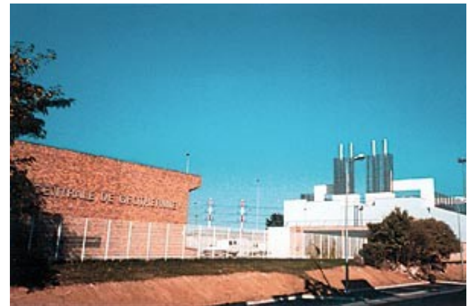
Centrale géothermique de Fresnes – photo ARENE IdF
