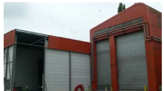
Silo de stockage
