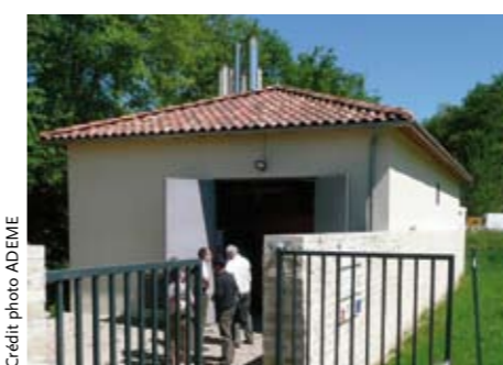
Chaufferie-bois de Caillac.
