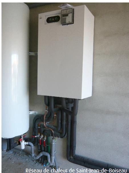
Les sous-stations murales peuvent fournir une puissance qui varie entre 10 et 150 KW pour le chauffage et pouvant aller jusqu'à 180 KW pour l'ECS.
