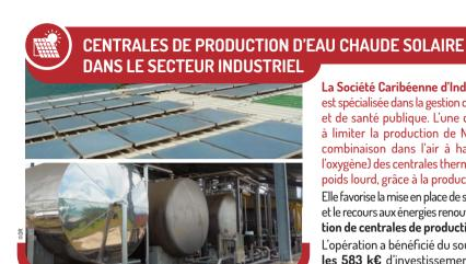
La centrale est prévue pour produire chaque année 945 kWh par m<sup>2</sup> et couvrir 86 % des besoins. Cette substitution d'énergie réduit la consommation de fuel de 38 MWh par an (soit 32,51 tep par an) et évite l'émission de 118 tonnes de CO<sub>2</sub>.
