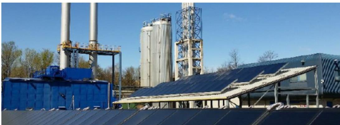
Illustration 11: Centrale solaire thermique (990m<sup>2</sup>) raccordée au réseau de chaleur de Varese en Italie - source INES
