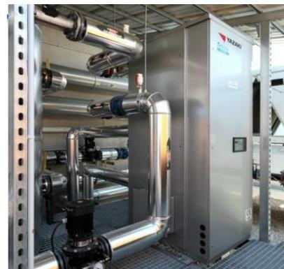
Figure 45: groupe froid à absorption (Serm)
