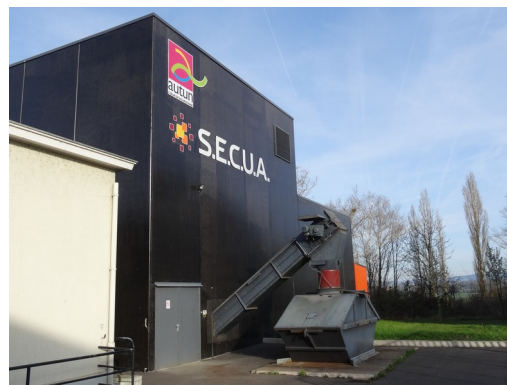
Chaufferie bois du PASA
