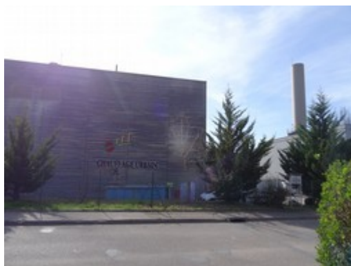
Chaufferie bois de St Pantaléon
