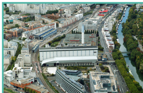
L'usine de traitement des déchets d'Issy-les-Moulineaux
